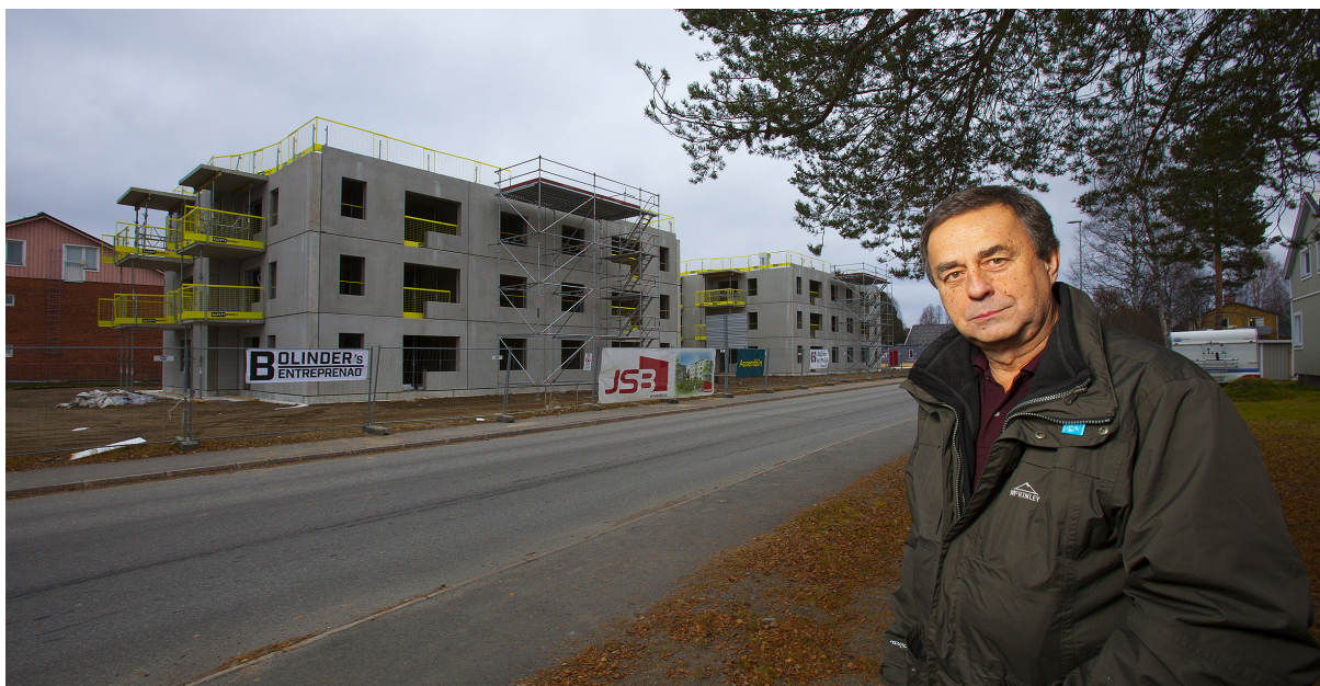
Full fart på lägenhetsbyggandet längs Mörttjärnvägen. Kommunstyrelsens ordförande Martin Norehn (S) följer uppförandet och konstaterar att inom en månad ska tak, dörrar och fönster vara på plats och värmen kopplas in för inomhusarbetena.
